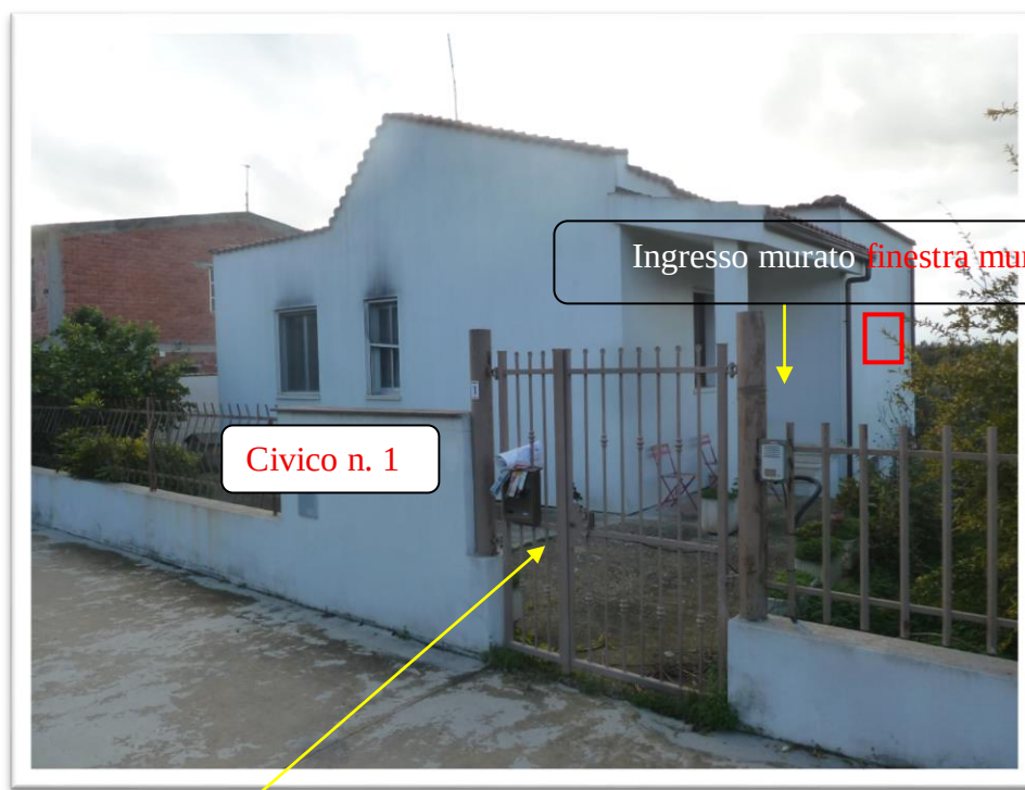
Foto n. 1 Prospetto e accesso sulla via Michelangelo 1
