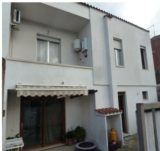
Foto n. 5 prospetto su via Camposanto
